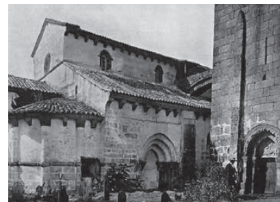
Igreja. Capela-mor e absídiolo antes das intervenções da DGEMN. Fonte: Boletim n.º 15 da DGEMN.
