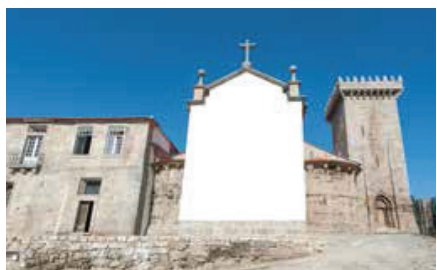
Igreja. Fachada oriental.
