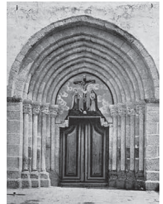
Igreja. Fachada ocidental. Portal antes das intervenções da DGEMN. Fonte: Boletim n.º 15 da DGEMN.
