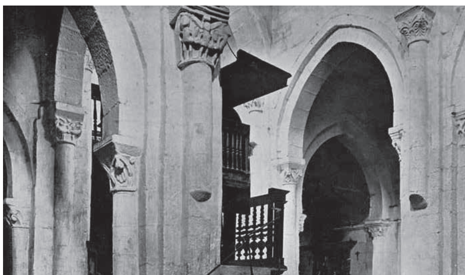
Igreja. Perspetiva interior antes das intervenções da DGEMN. Fonte: Boletim n.º 15 da DGEMN.
