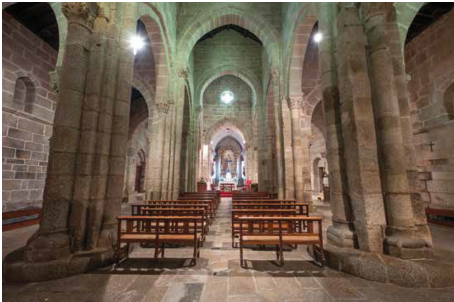
Igreja. Vista geral do interior a partir da nave central.
