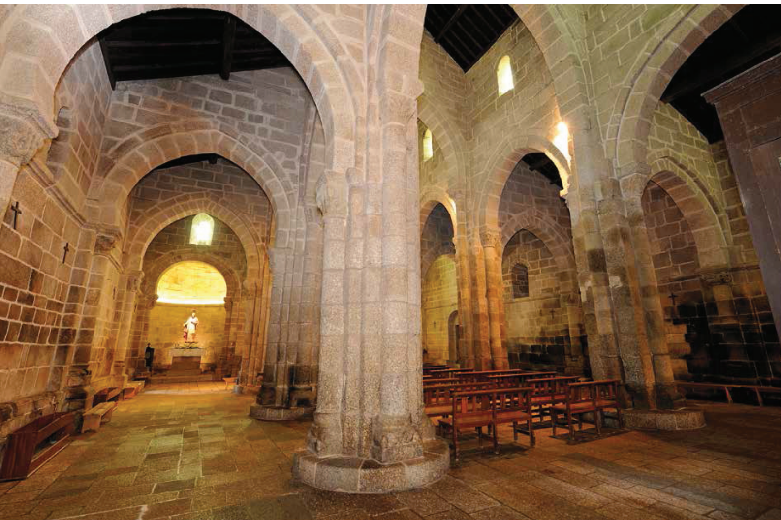
Igreja. Naves. Arcos diafragma.
