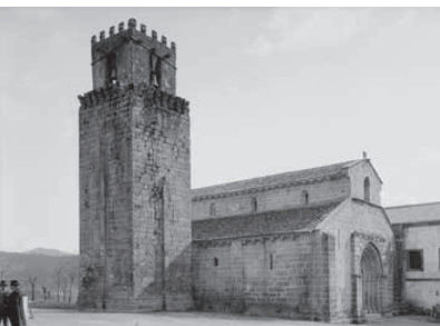
Igreja e torre antes das intervenções da DGEMN. Fonte: arquivo IHRU.
