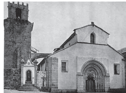
Igreja. Fachada ocidental e torre antes das intervenções da DGEMN. Fonte: Boletim n.º 15 da DGEMN.
