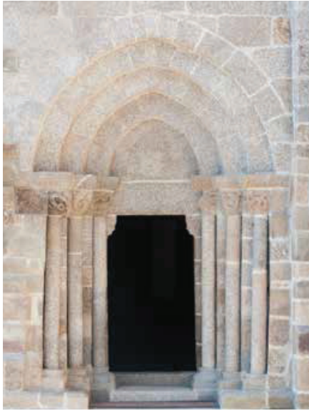
Igreja. Fachada norte. Nave. Portal.
