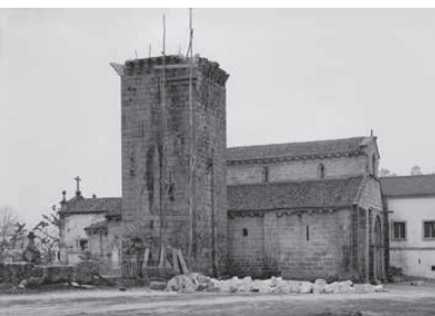
Igreja e torre durante as intervenções da DGEMN. Fonte: arquivo IHRU.
