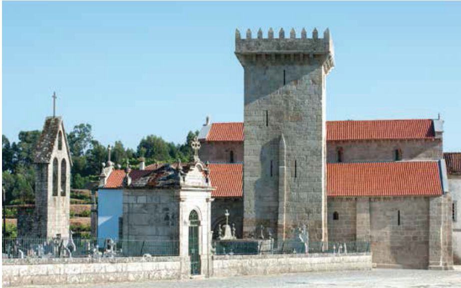
Igreja e torre. Fachada norte.
