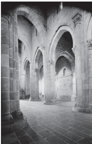
Igreja. Perspetiva interior depois das intervenções da DGEMN. Fonte: arquivo IHRU.
