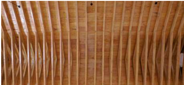
Teto da nave.
