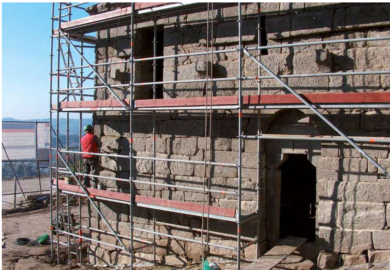
Refechamento das juntas.
