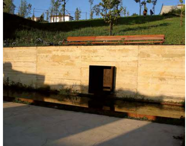
Muro de taipa e tina de água.
