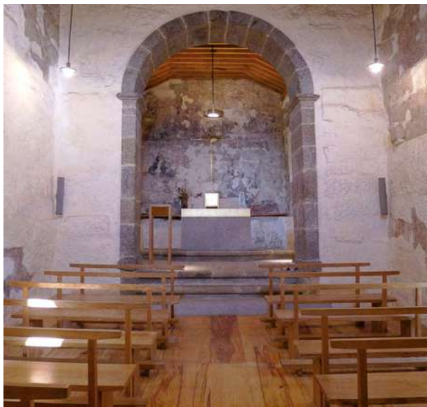
Pavimento da nave em madeira de pinho manso nacional.
