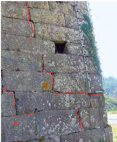
Localização dos principais danos estruturais na fachada.
