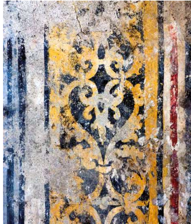
Parede norte da capela-mor e pormenor da mesma parede, respetivamente, onde se observa uma barra decorativa executada com estampilha.
