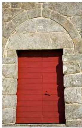
Portal principal da Igreja.
