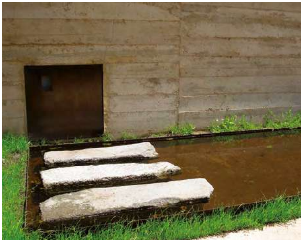
Poldra na tina de água de acesso ao quadro de redes.
