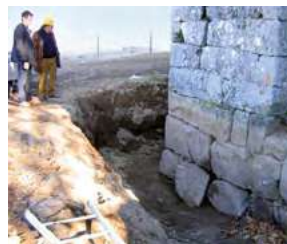
Descalçamento da fundação.
