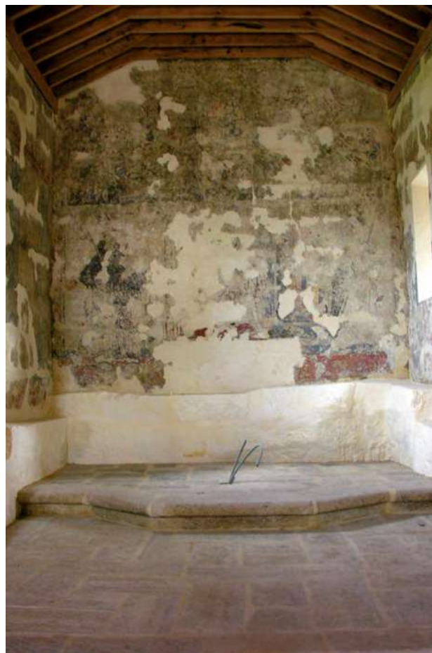
Aspeto da parede fundeira da capela-mor após a conclusão dos trabalhos.
