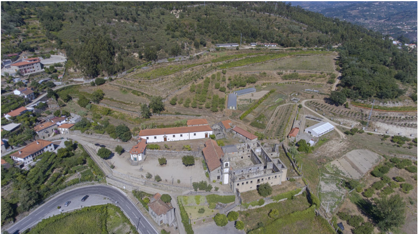
Mosteiro antes da intervenção
