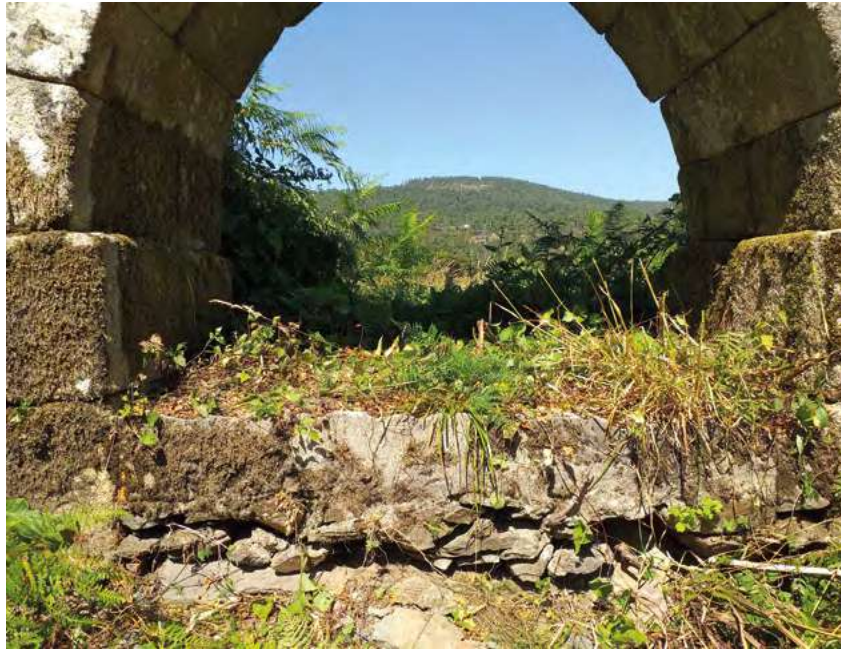
Arco da Campeã (Vila Real). Pormenor do plinto.
