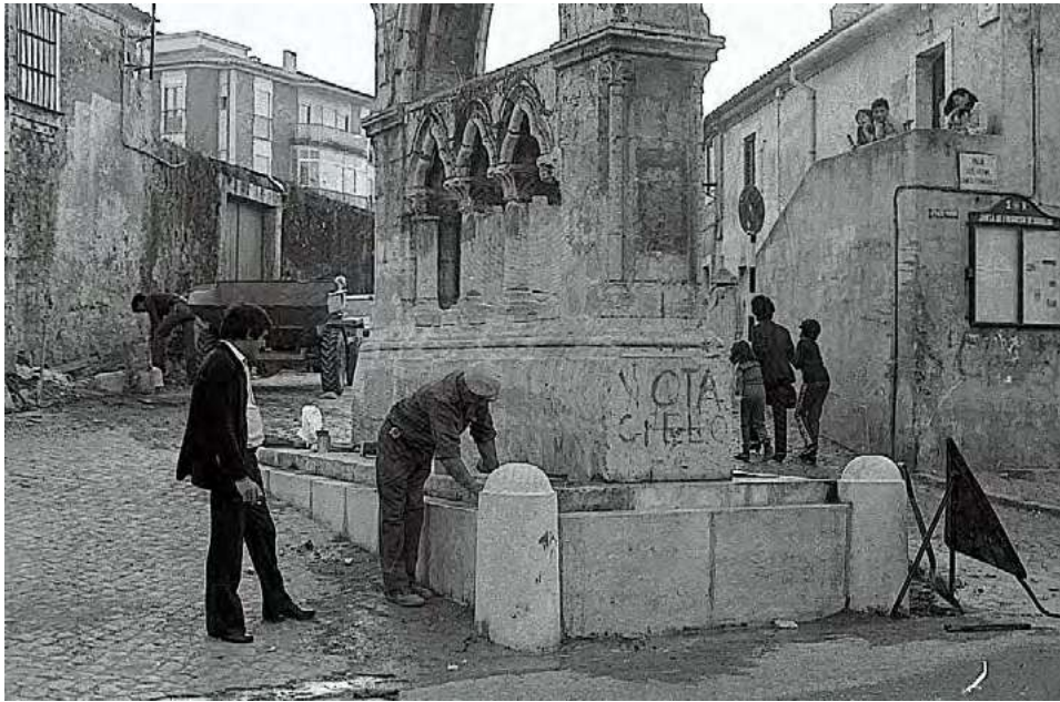
Memorial de Odivelas (Odivelas). Trabalhos de reparação em 1983.
