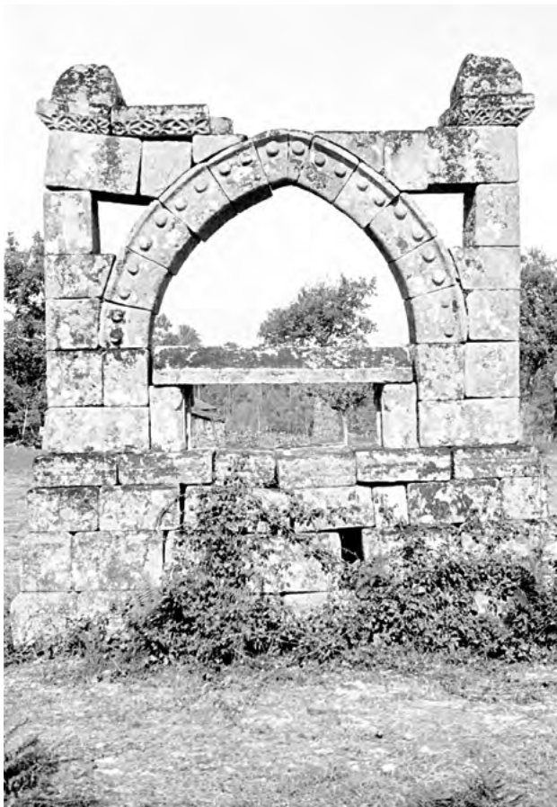
Memorial da Ermida (Penafiel) em ruína, por volta de 1935. Foto: Câmara Municipal do Porto. Arquivo Histórico. Identificador 264064.
