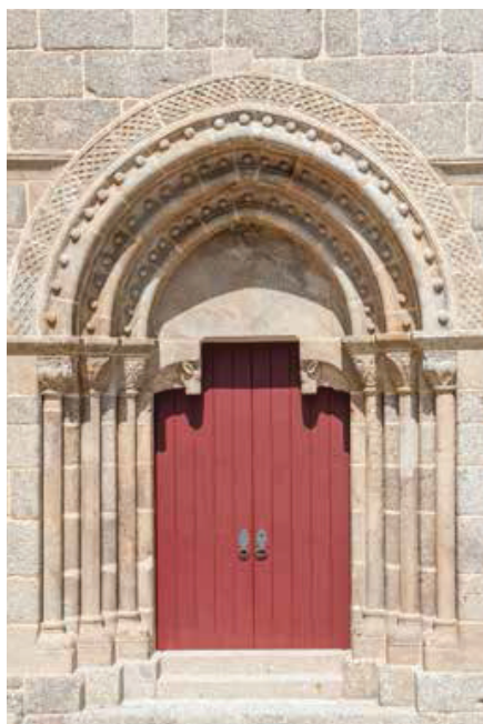
Fachada ocidental. Portal.
