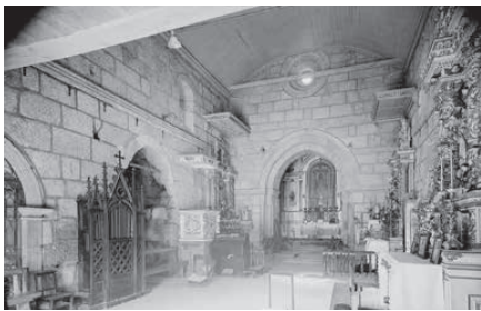
Nave antes das intervenções da DGEMN. Fonte: arquivo IHRU.
