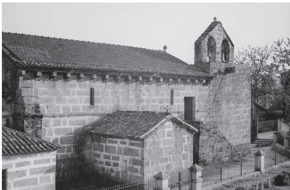
Fachada norte antes das intervenções da DGEMN. Fonte: arquivo IHRU.
