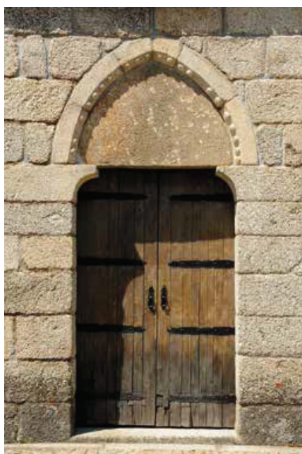
Fachada sul. Nave. Portal.
