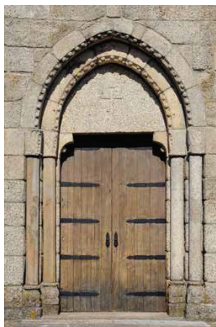
Fachada ocidental. Portal.
