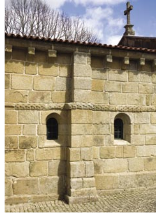
4. Os contrafortes escalonados destinam-se a minorar a infiltração das águas pluviais no interior dos muros. O friso esculpido retoma temas de tradição hispano-visigótica, numa solução muito própria do românico do Vale do Sousa.
